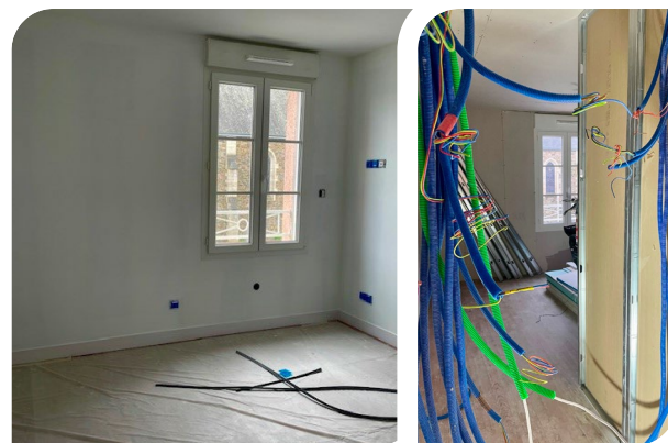
Chantier en cours des logements
