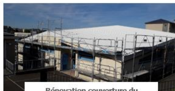
Rénovation couverture du gymnase Le Verrier à Saint-Lô
